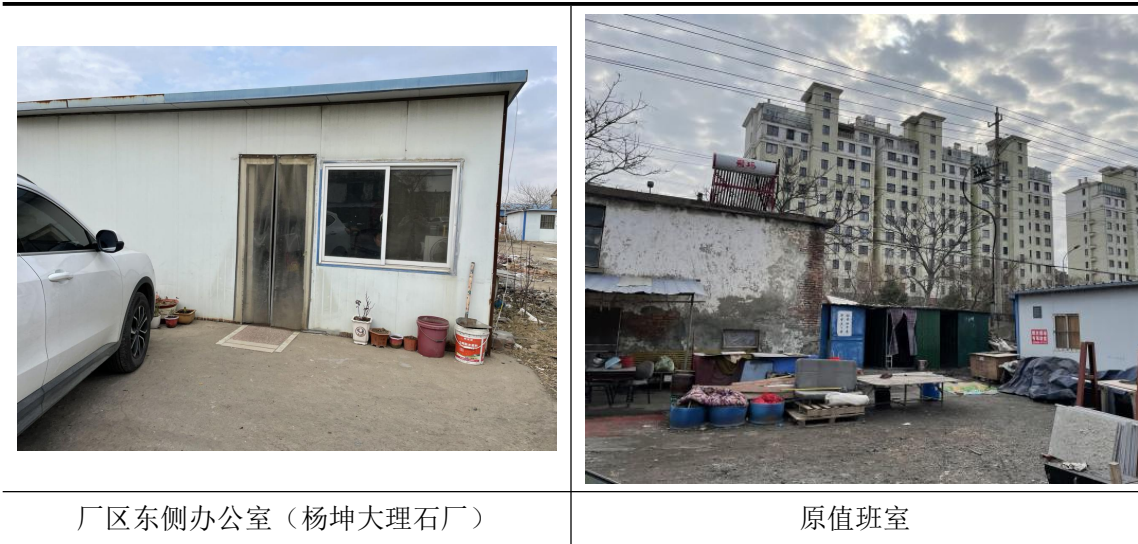
图 4.2.1-2 地块内现存构筑物照片
