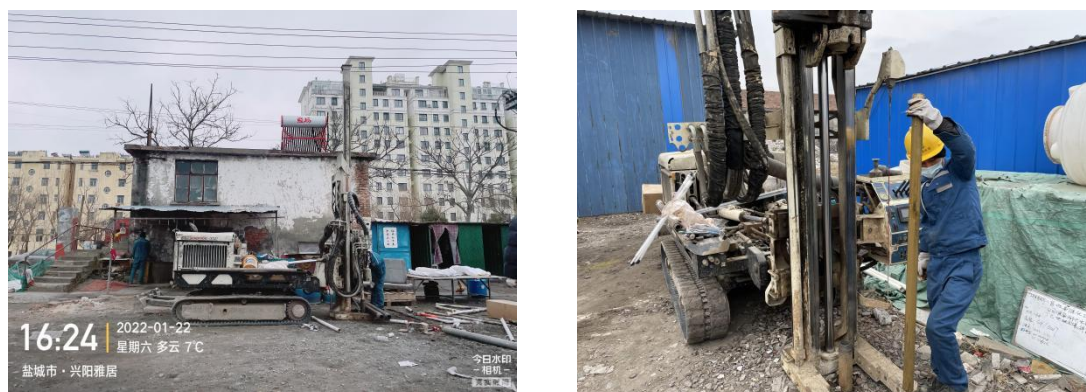
图 5.2.1-1 直推式土壤采样设备
